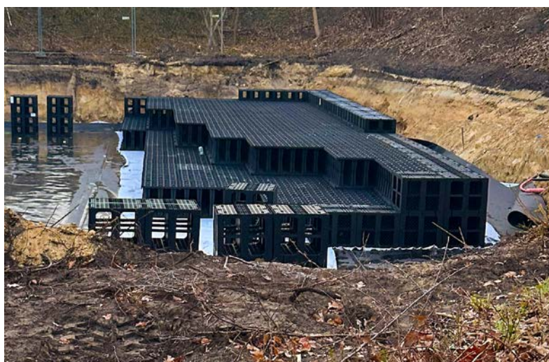
Einbau der Regenwasser-Rigolen in der Bäckerstraße
